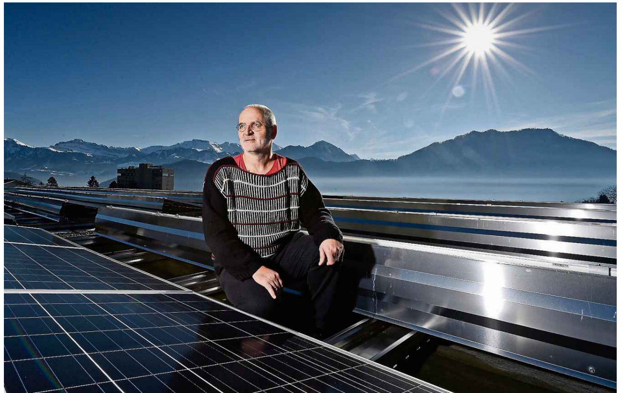
Paul Zimmermann, Präsident der Energiegenossenschaft Rigi Süd, auf dem Dach des Oberstufenschulhauses Weggis. Die Solaranlage wird von der Genossenschaft betrieben.
